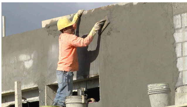
Rellenos estructurales - Mayo
