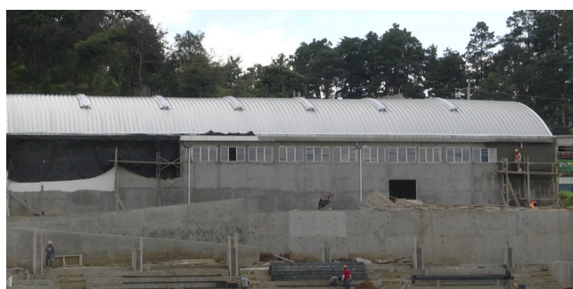
Construcción polideportiva - Septiembre
