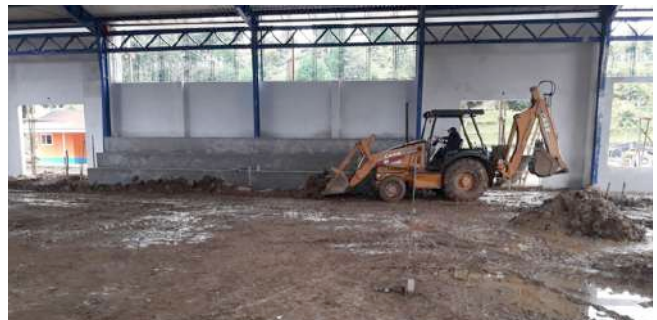
Al finalizar el año se logró un 57.58 % de avance en la construcción del gimnasio polideportivo de San Juan Chamelco, Alta Verapaz
