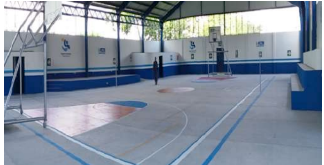
El gimnasio polideportivo construido en la aldea Ciénaga Grande, Cabricán, Quetzaltenango fue entregado en el último cuatrimestre del año 2017
